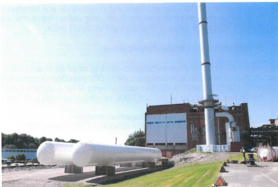
Borregaard har gjennomført flere NOx-reduserende tiltak på sin fabrikk i Sarpsborg som NOx-fondet har støttet. Et tiltak om å gå over til gassdrift på fyringskjelene har alene ført til en NOx-reduksjon på 179 tonn NOx per år. Foto: Borregaard
